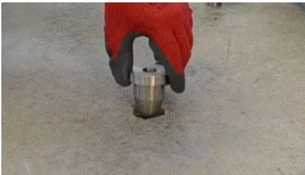
Figura 3. Instalación de la Guía de perforación.
